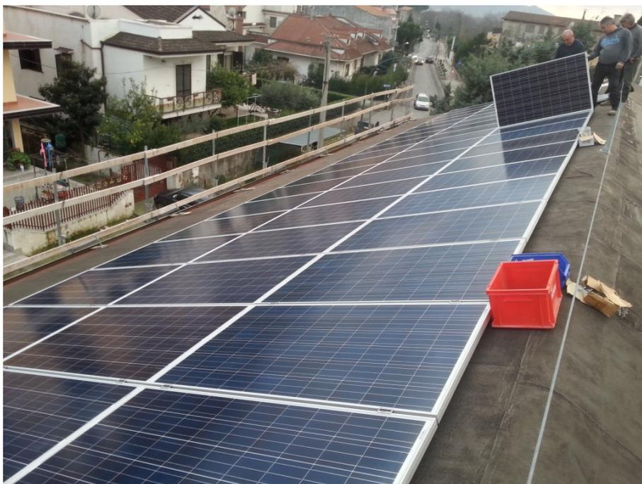
Impianto fotovoltaico con pannelli policristallino sul solaio di copertura della palestra
