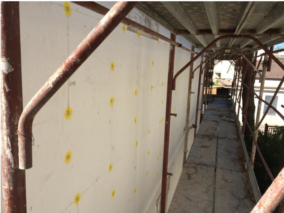
Cappotto termico della facciata nord – Posa pannelli in EPS con collante specifico e fissaggio meccanico
