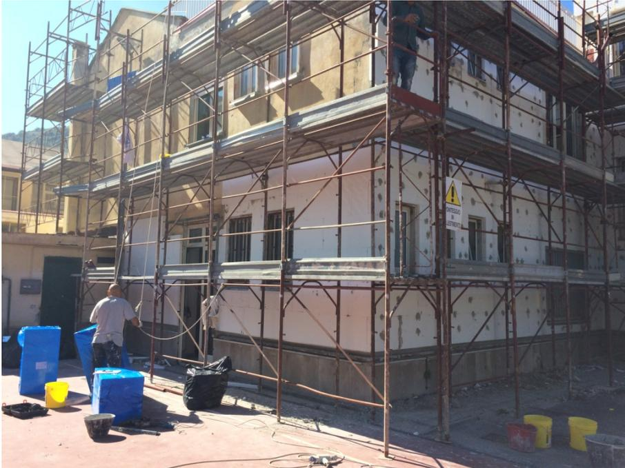
Cappotto termico della facciata nord- est – Posa pannelli in EPS con collante specifico e fissaggio meccanico
